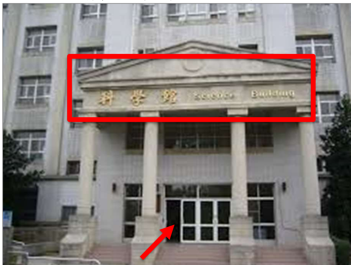
科學館正門一樓內左側 I109 教室
